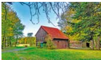
Vorbei am ehemaligen Forstgebäude Hinzel
